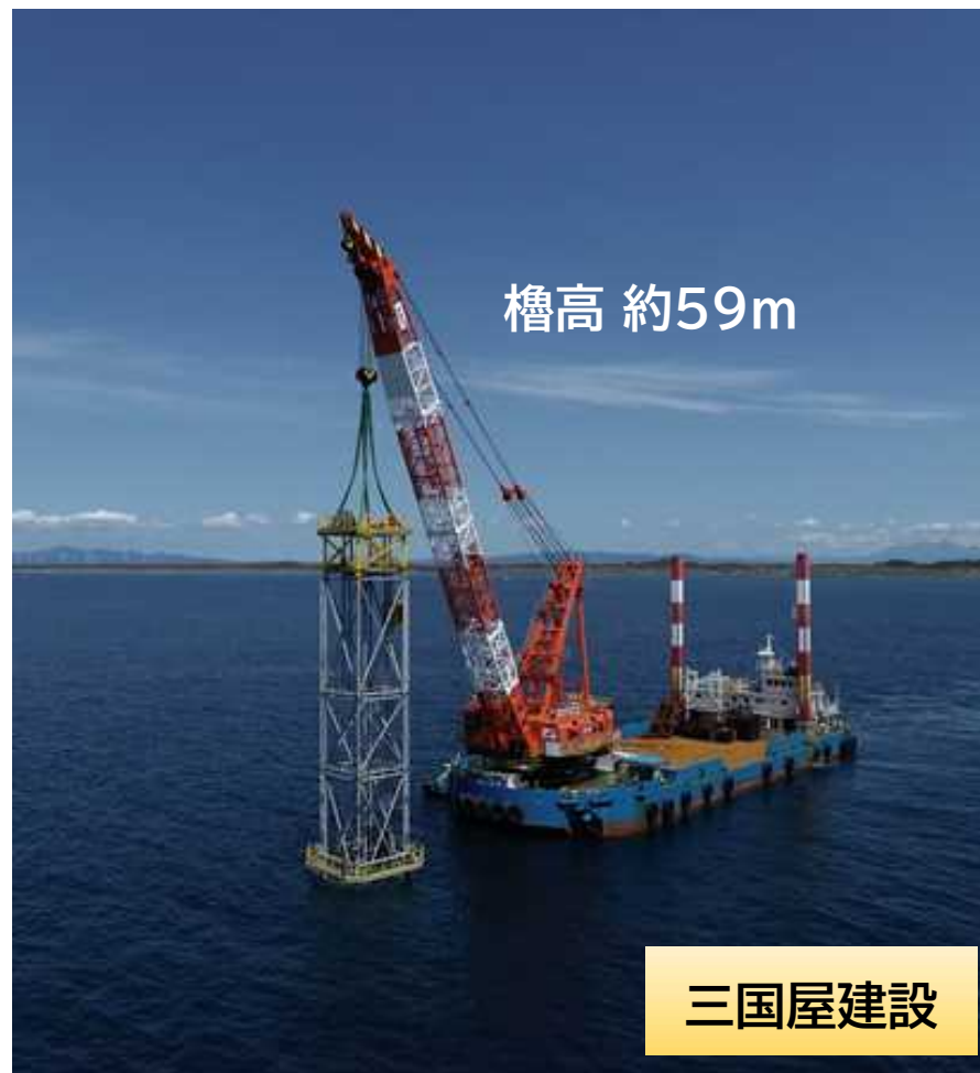
“大型鋼製櫓”(高さ調整可能) ※ 改良中(特許取得:2件)
