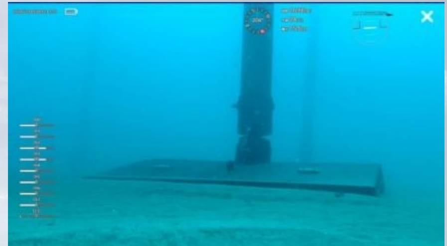
－ 海底に設置した仮設構造物 －
