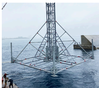
現場設備の改善:凸凹のある海底への対応
