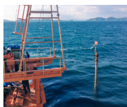
ガイドパイプ残置状況
