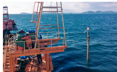
ガイドパイプ残置状況
