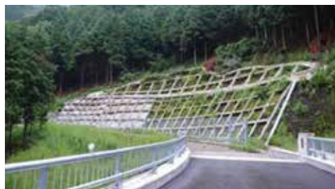
のり面对策工
