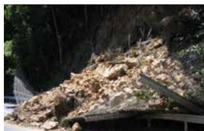
被災箇所の二次災害監視
