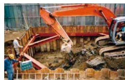
浄化(汚染範囲掘削除去工事)
