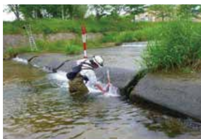
河川構造物の点検
