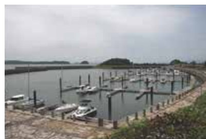
漁港・港湾施設
