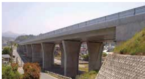
橋梁・高架橋
