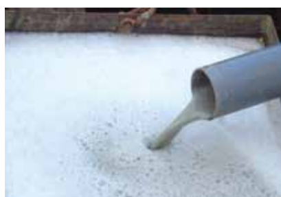
高分子ポリマー泥剤を使用した気泡水
