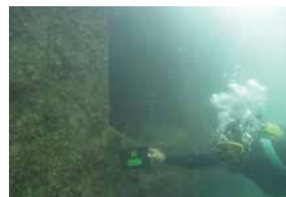
漁港・港湾施設の点検
