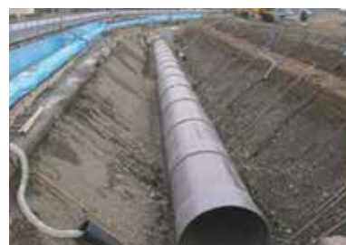
農業水利施設
