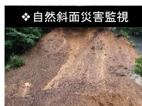
❖自然斜面災害監視 被災斜面における 二次災害発生の斜面監視
