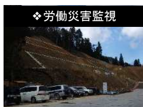
❖労働災害監視 道路建設における 切土法面の安全監視
