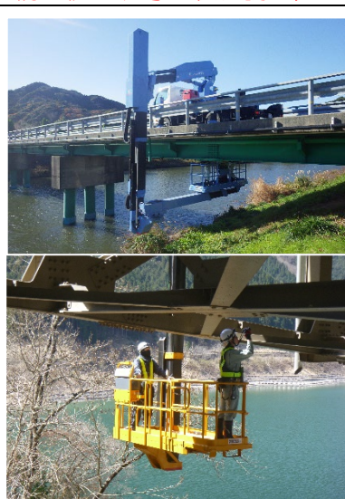
橋梁点検車による目視調査
