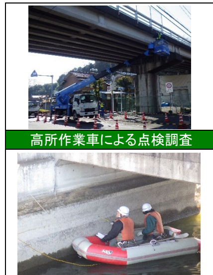
船上(ボート)による点検調査
