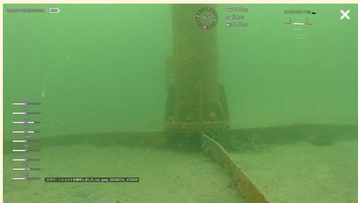
ROVが捉えたスパッド台船脚部の着底状況(水深約9m)
