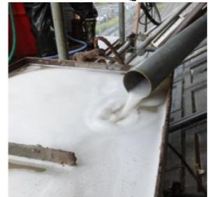
掘削中の微細気泡懸濁水
