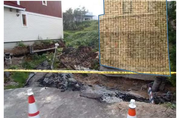
家屋周辺地盤の沈下 玄関ポーチが沈下
