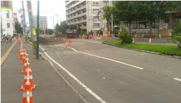
③元町地区 道路の変状状況。道路が陥没し、電柱が傾斜している。
