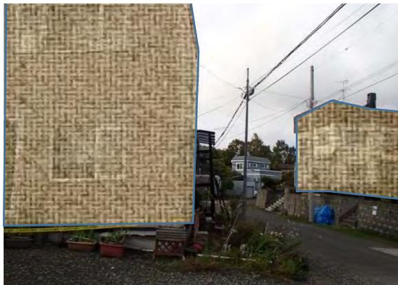
家屋周辺地盤の沈下 不等沈下で家屋が傾斜
