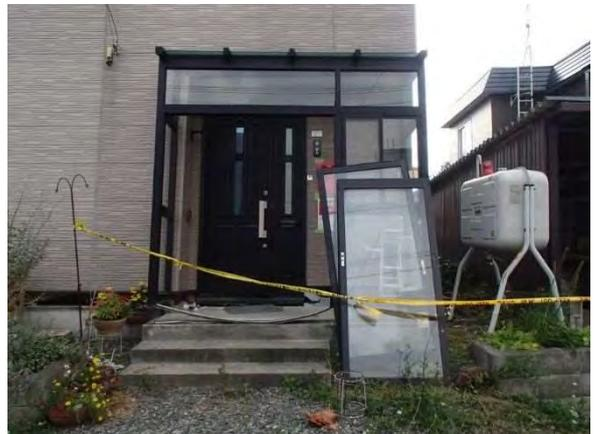
家屋周辺地盤の沈下 玄関ポーチが沈下
