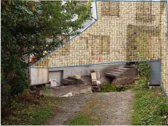
家屋周辺地盤の沈下、陥没
