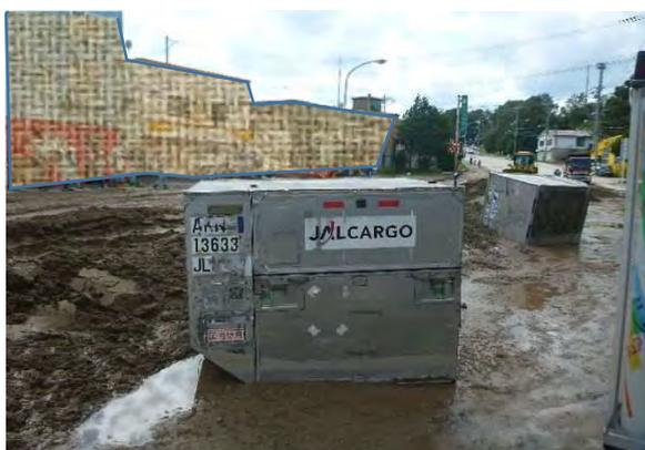
① 斜面上方より流出した火山灰質土が、最も下流側の道路で堆積している。上流の運送会社から航空コンテナが、流出土砂とともに移動したものの。
