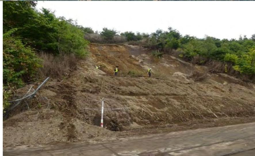
上記写真の黄色矢印の崩壊地の様子 崩壊厚は5m程度
