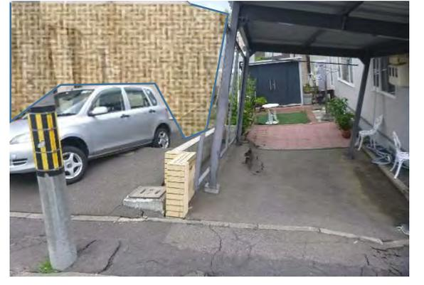
⑥ 急傾斜した駐車場。左側の車は段差の発生により後輪が宙に浮いている。
