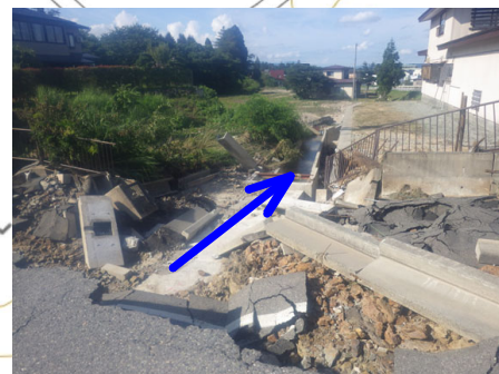
P2 縦断排水が→の方向に 流下し崩壊した
