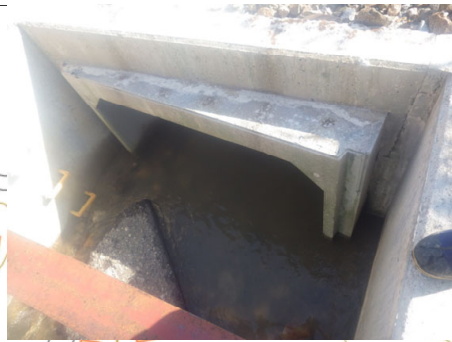
P4 横断BOXは変状無し
