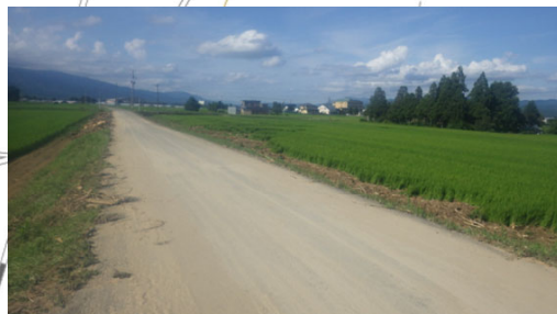
P7 萩生川左岸側の越流土砂
