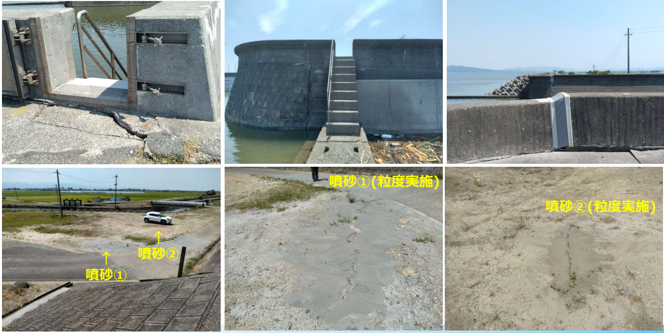
④ 潮遊沼南側の水門付近の海岸堤防、堤内地盤(堤防傾斜、噴砂)
