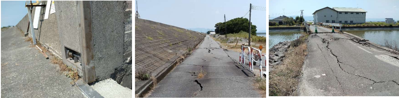
④ 潮遊沼南側の水門付近の海岸堤防、堤内地盤(堤防傾斜、噴砂)
