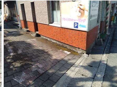
⑥ 張出家屋基礎・護岸の破損
