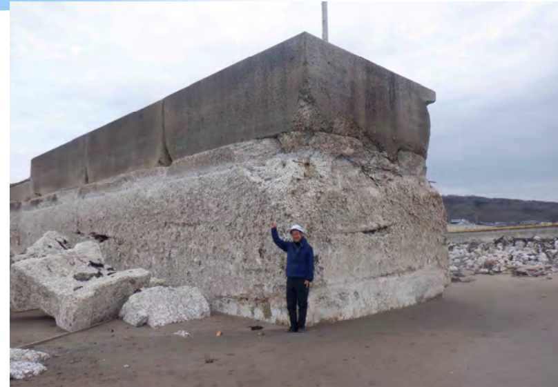
Loc.3(港湾施設基部まで露出)
