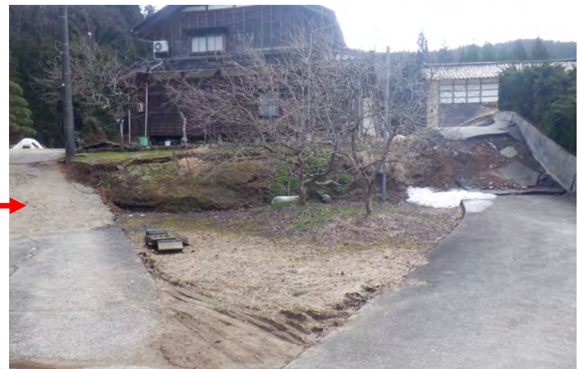
Loc.5(家屋の前に大きな段差が生じている)
