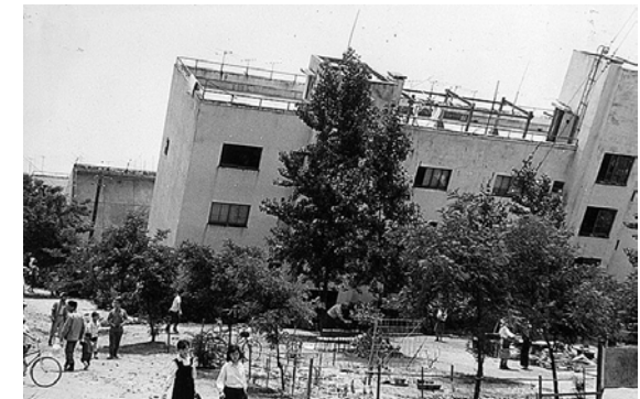
川岸町県営アパートの傾斜 提供：防災科学技術研究所
