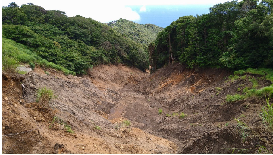
崩壊地上部から下流方向を望む
