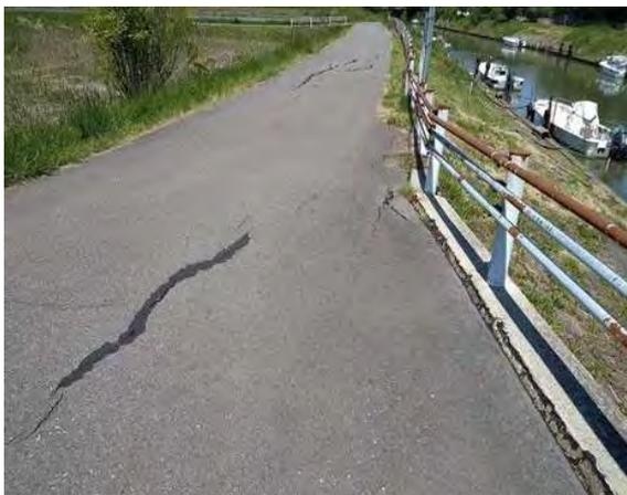
アスファルトの亀裂と沈下
