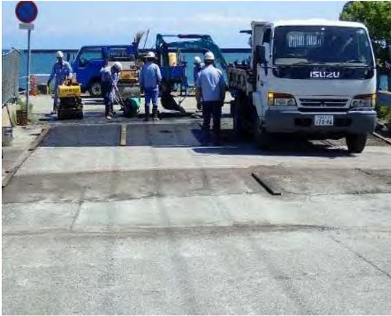
道路に段差が発生。補修施工作業中。
