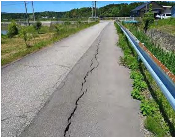
アスファルト亀裂。川側に開口。
