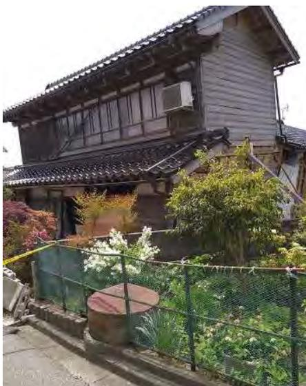
切り盛り境の家屋変状。大きく破損し倒壊寸前。
