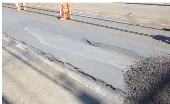
道路舗装面の沈下
