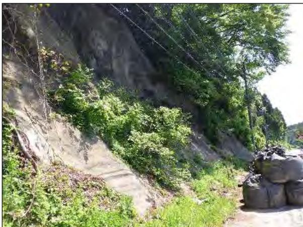
⑨ 吹き付け工斜面の崩落
