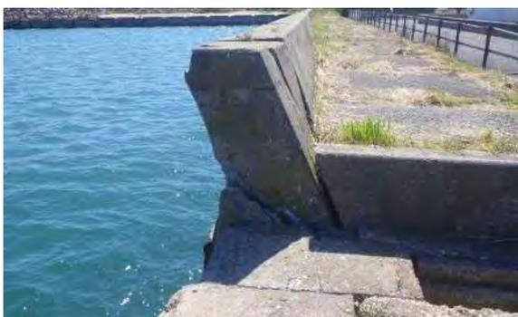
護岸コンクリートの亀裂
