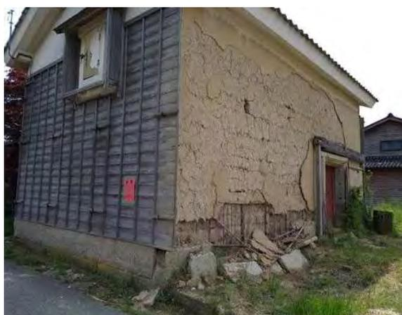
土蔵の壁の崩壊(土蔵は弱い傾向が見られる)
