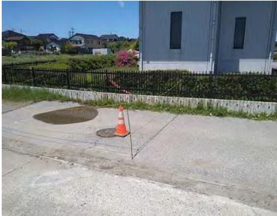
マンホールの浮き上がり。道路の沈下亀裂。
