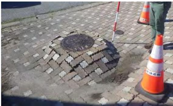
マンホール周囲沈下。噴砂確認。
