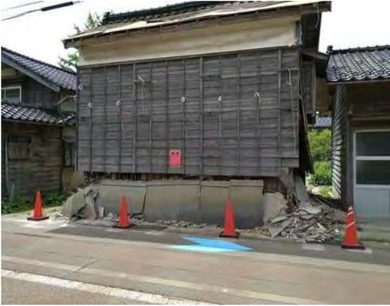
土蔵の基礎、壁面破損。
