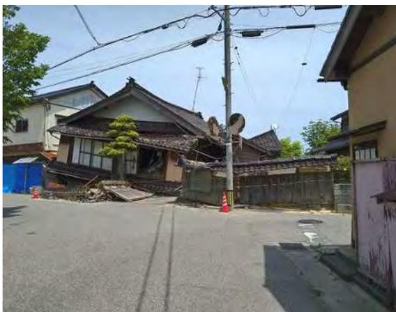
大型家屋の倒壊。隣も含めてゆるく海側に傾斜している。地盤の違いと考えられる。
