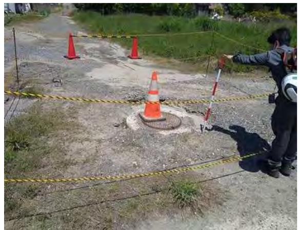
マンホールの浮き上がりと周囲の沈下。
