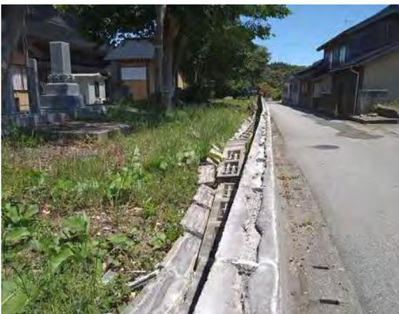
ブロック塀倒壊。無筋部分が基本的に崩落。
