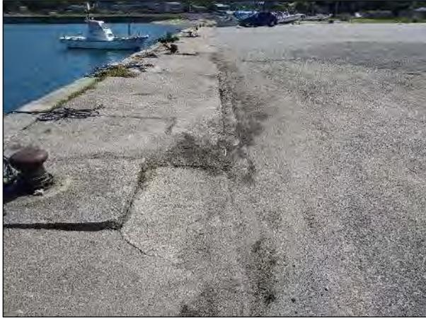
① 岸壁の沈下
