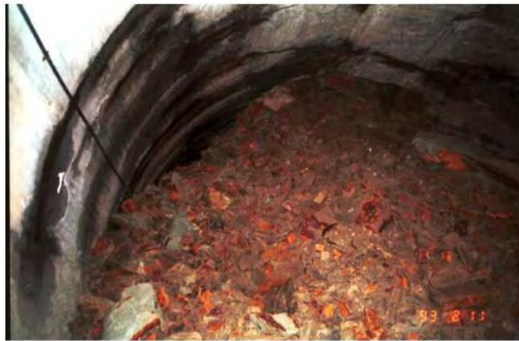
図Ⅱ-2-1 天井が崩落した木ノ浦トンネル(1993年2月11日撮影)
