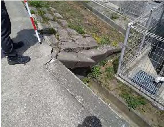
堤防沈下による破損。フェンスには変状なし。
