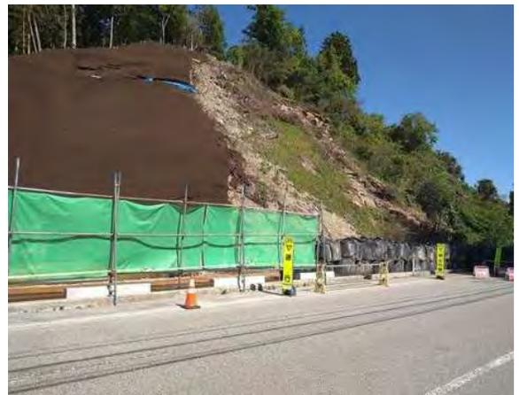
切土施工中に表層が崩落。
