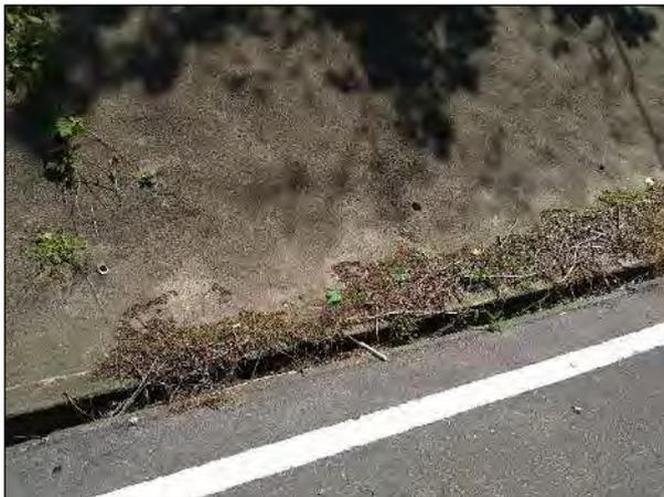
⑤ 吹付け工斜面の押し出し
