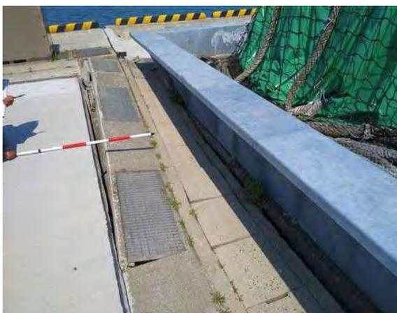
先端部背面沈下。側溝破損 50cm 程度は沈下。
