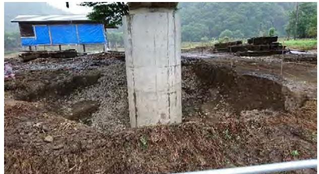
②蛇行部の内岸側を越流した洪水流は、浸水被害をもたらすとともに、橋脚の複数の基礎部を大きく洗掘している。
