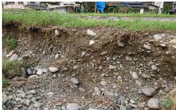
⑪ 球磨川の堤防の上層部の材料は礫混じりの砂
