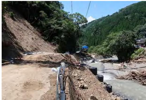
⑨⑩ 渡地区の右支川の上流約 3km。古い橋が流木等で堰き止められて流出し、左岸の斜面が崩壊して河道が堰き止められ、その崩壊で段波が生じ、それが下流の特別養護老人ホームに到達した可能性がある
