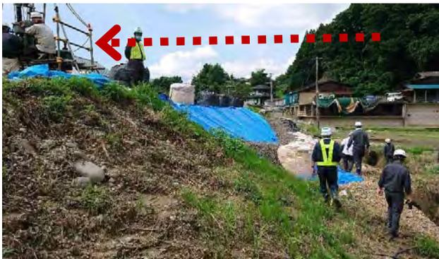
③大垣排水樋管の堤防破堤箇所 (L=10m) 堤防天端の2.3m上を堤内地から川側へ越流したとみられる
