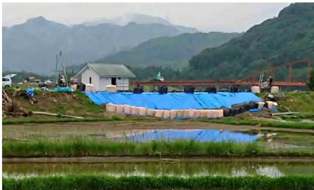
①紅取橋下流の堤防破堤箇所 (L=20m)
