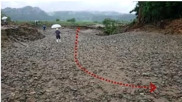
①山付き部の切れ目からブロック護岸の天端を壊して流水が越流し、農耕地が侵食されている。旧河道の形状に沿って侵食された土砂が流れている。
