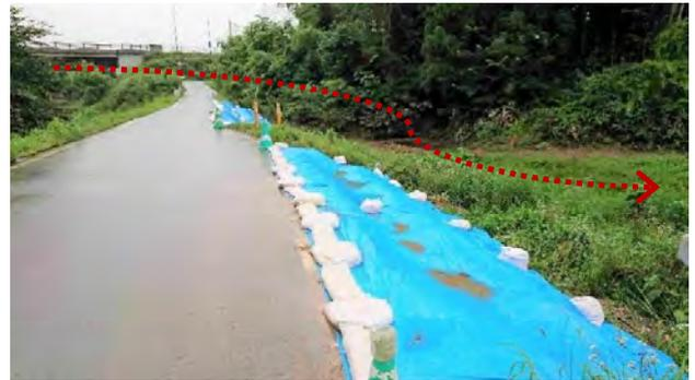
③長島橋上流右岸の堤防の損壊箇所。洪水流は、この蛇行部の暫定堤防を越流している。
