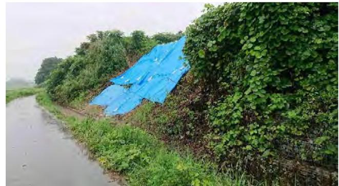
⑦第2 遊水池の外側 (西側) の河岸段丘では複数の崩壊が発生している。左右には布団かごが設置されている。
