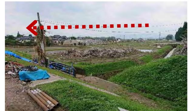
④大垣排水樋管の堤防決壊箇所は堤内地からの逆越流による破堤と考えられている
