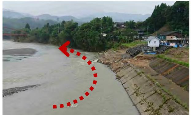
②紅取橋下流の堤防破堤箇所は水衝部に樋管が位置する
