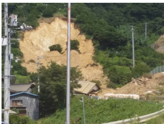
県道北側の崩壊（遠望）
