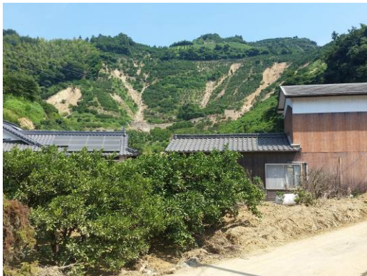
崩壊③：遷急線付近からの崩壊 擁壁の脇から家屋に土砂が流入
