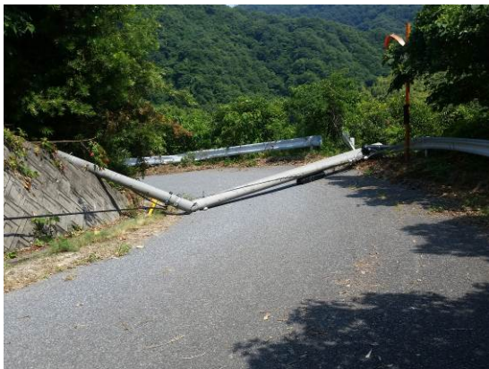
林道沿いの電柱が倒壊 根元から折れている。原因不明。風？
