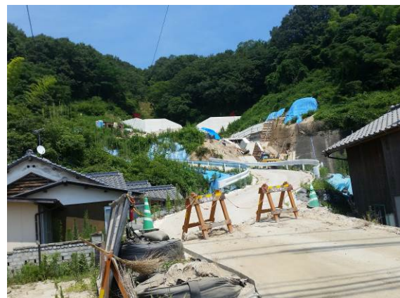
建設中の砂防堰堤
