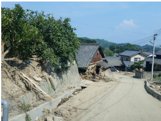
土石流被害とみられる家屋破損
