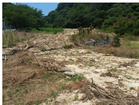
主谷を流下した土石流跡
