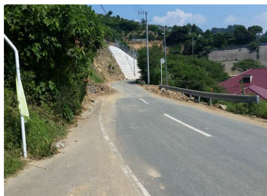
土石は国道を超えて海岸付近まで達した
