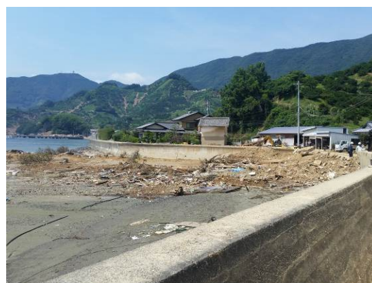
崩壊①②の流下土砂-2
