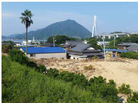
戸板川の土石流被害。 下流側を撮影。
