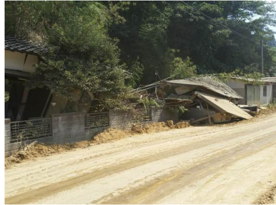
崩壊③で倒壊した家屋
