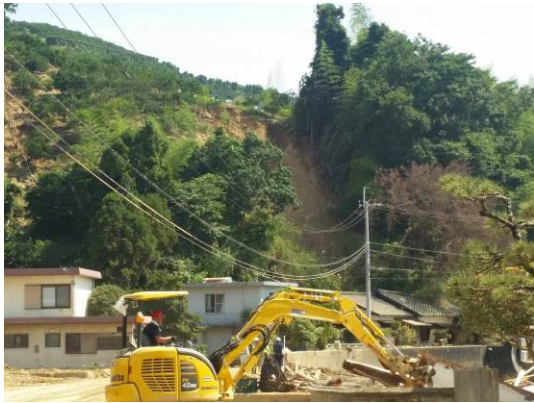
崩壊③：遷急線付近からの崩壊 擁壁の脇から家屋に土砂が流入
