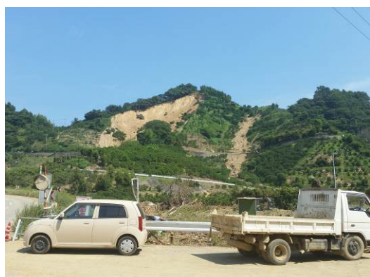
県道南側の崩壊（遠望）
