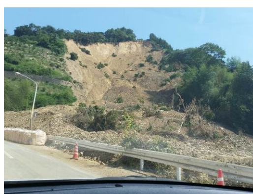
県道南側の崩壊（近傍）
