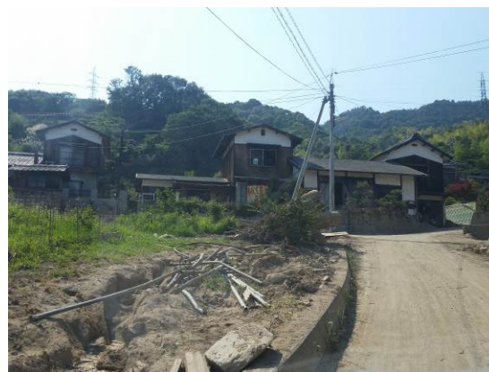
道路及び周辺の土地には土石流跡とみられる土砂が堆積
