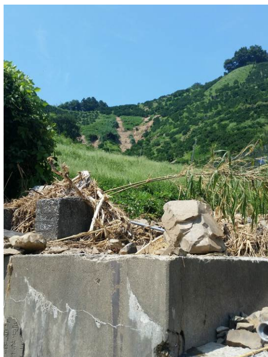
写真中央の表層崩壊(極表層)をトリガーとする土石流と推察される
