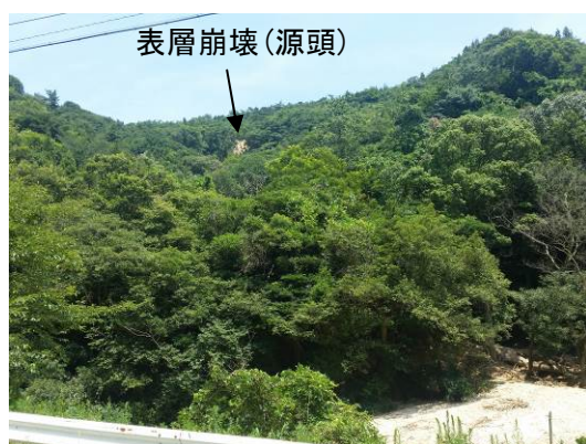
土石流溪流の全景
