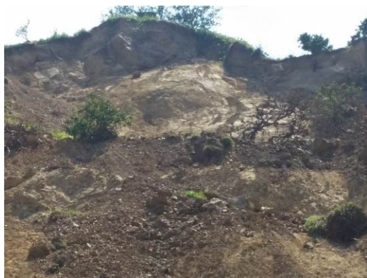
崩壊斜面。軟岩クラスの砂岩が露出。
