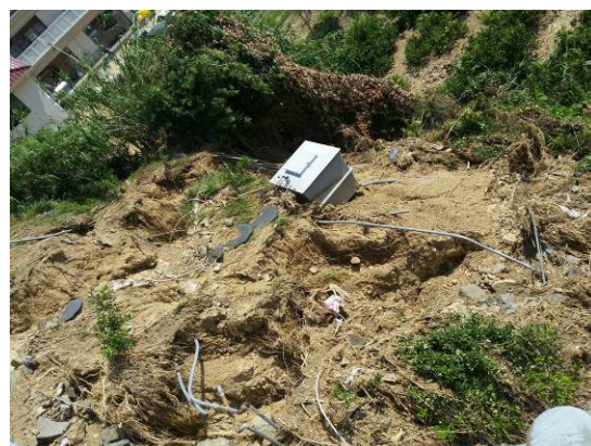
国道谷側に残存する崩壊土砂
