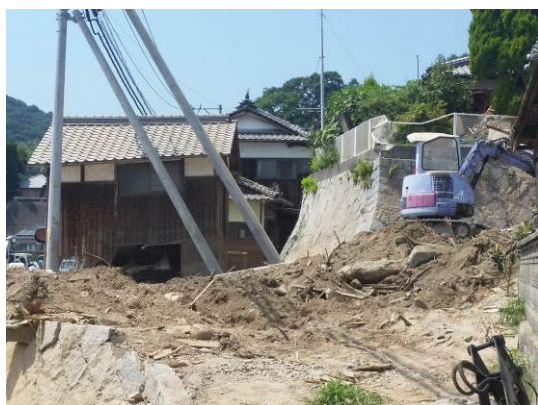
土石流の末端部。家屋倒壊。
