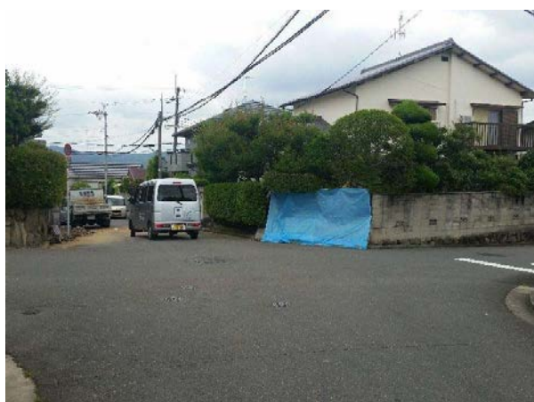
TN-03_01 南平台(避難勧告地域) ブロック塀の倒壊
