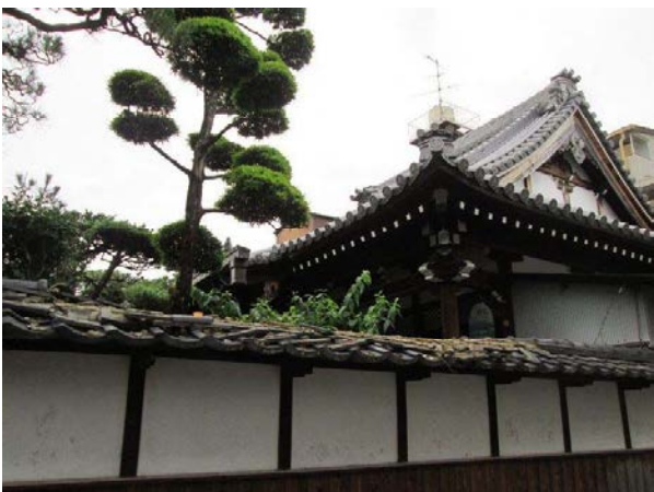
I-02_03 浄教寺 屋根瓦の崩壊
