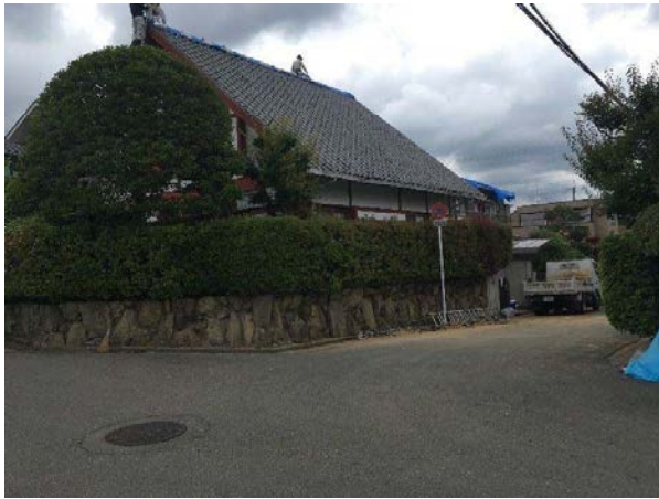
TN-04_01 南平台(避難勧告地域) 屋根瓦の落下 (18 日に落下, 19 日 AM には瓦葺きかえ完了)
