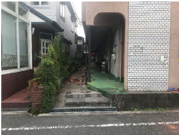
I-04_03 片桐町 屋根瓦の落下
