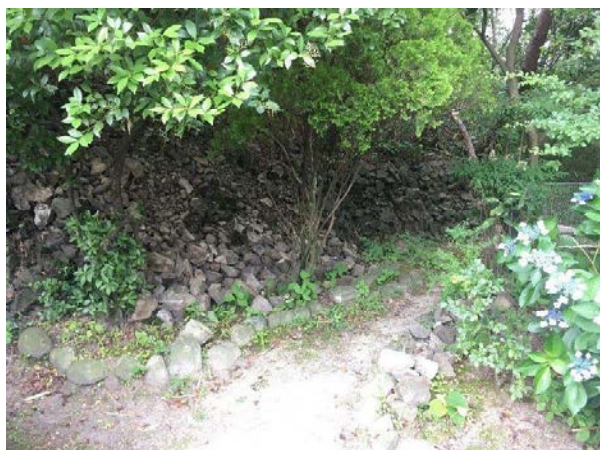
TN-01_01 南平台(避難勧告地域) 石積みの崩落
