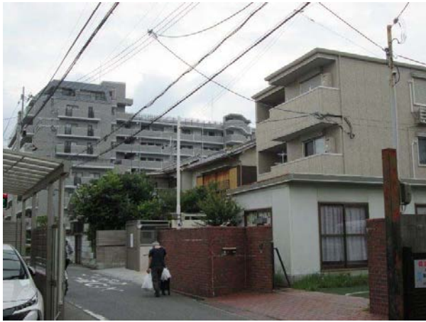
I-04_01 片桐町 屋根瓦の崩壊（右が東）
