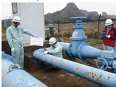
Inspeção de Estruturas
