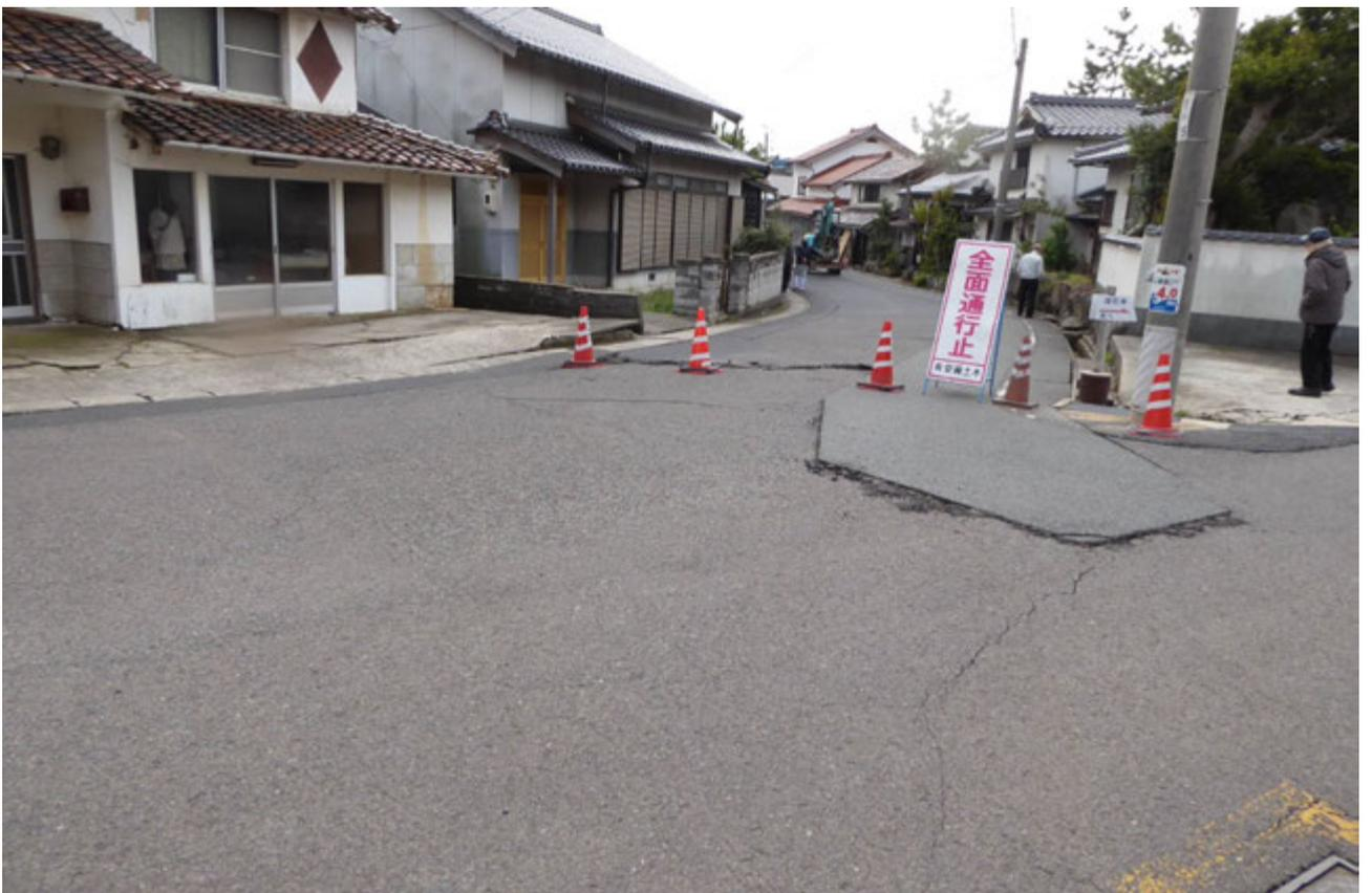
路面の沈下
