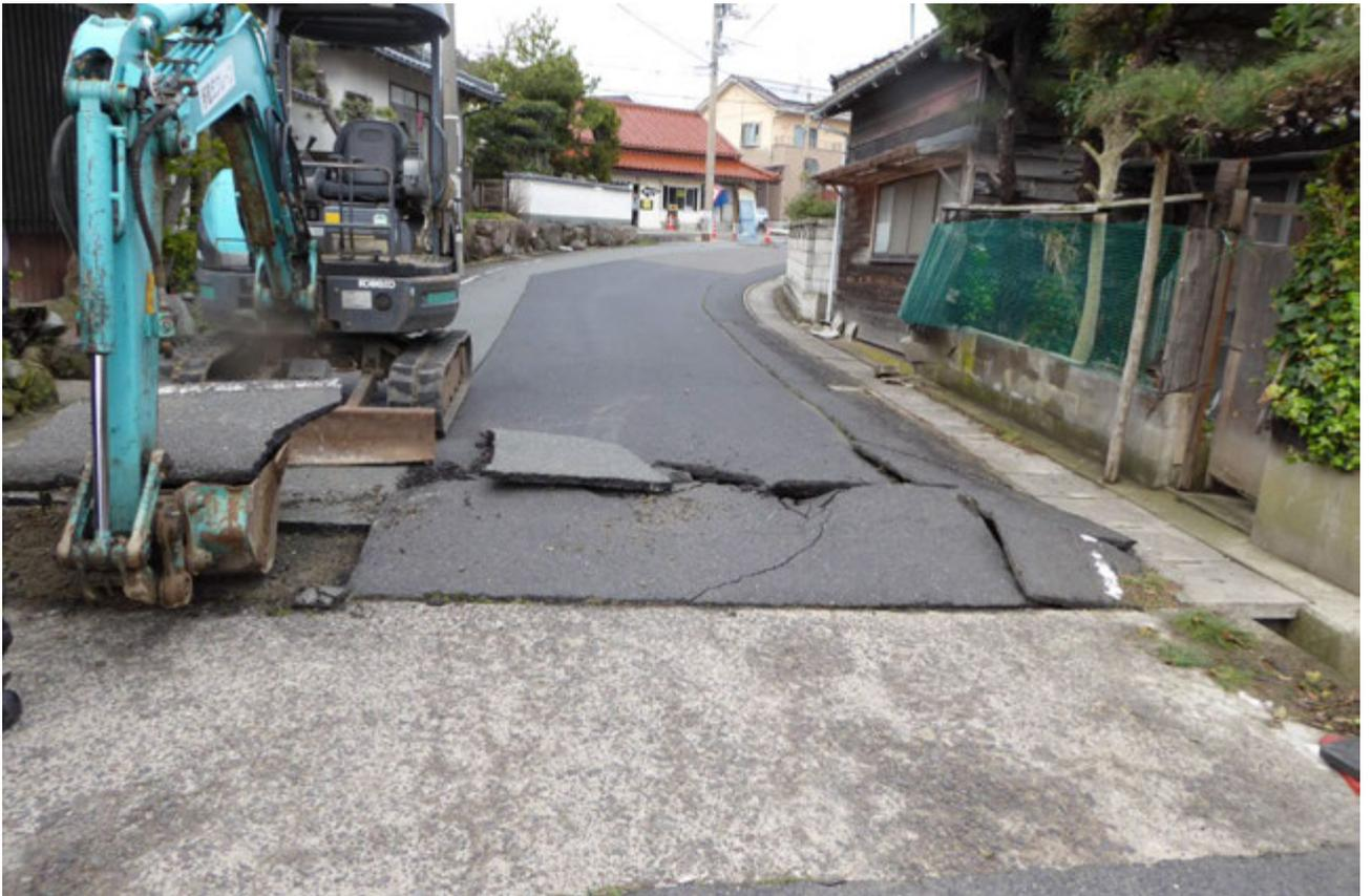
路面の沈下
