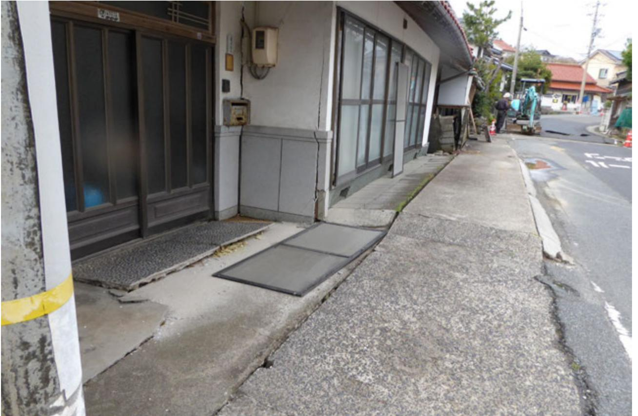
液状化と思われる沈下で損傷した家屋
