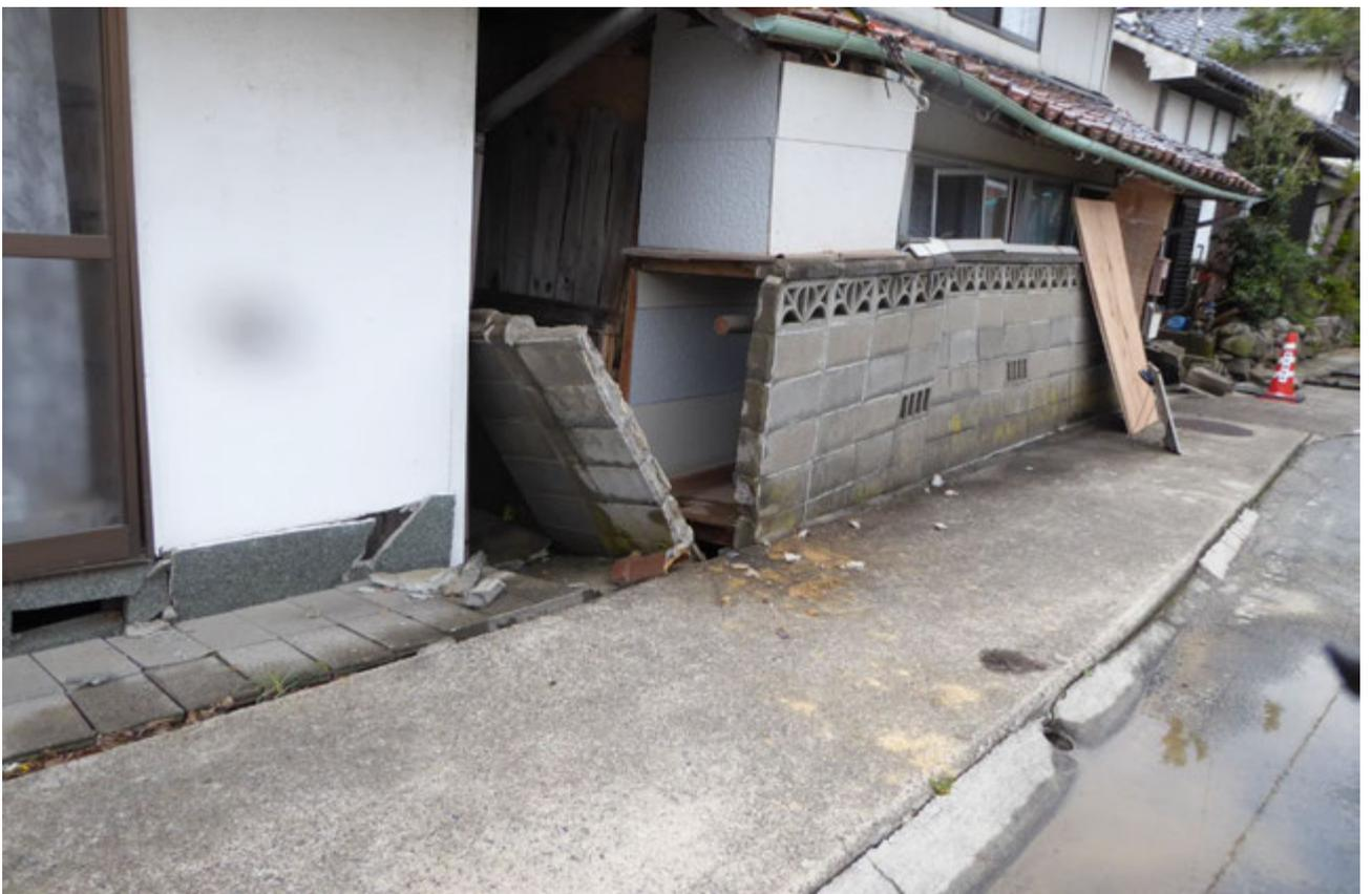
ブロック擁壁の転倒と家屋基礎の損傷
