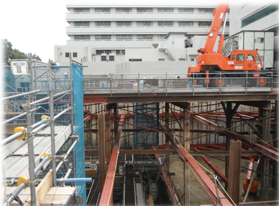
建設工事状況
