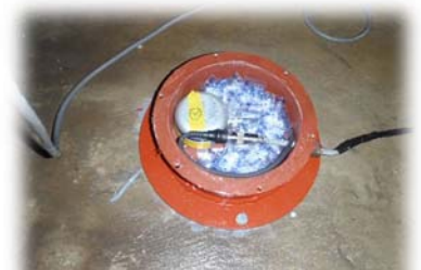
振動レベル計設置状況
