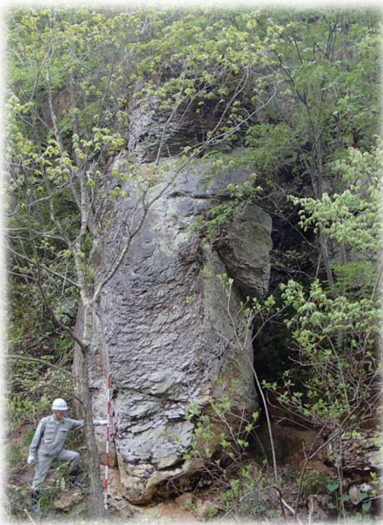
監視対象の不安定岩塊
