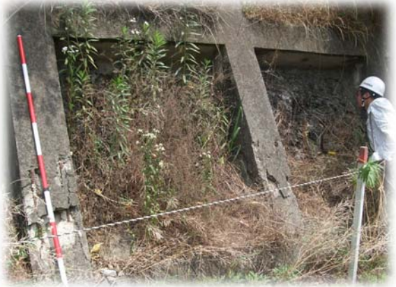
専門技術者による定期的な法面点検
