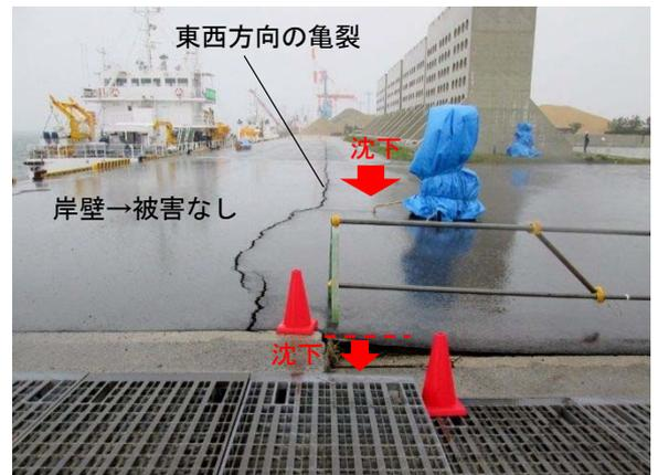
写真 2-4-2 熊本港(新港)の岸壁背後の不同沈下
