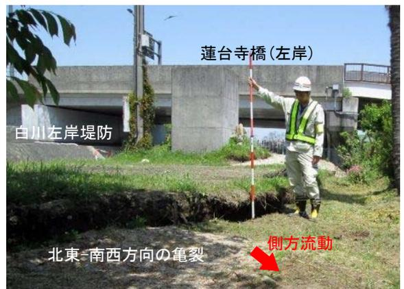
写真 2-3-7 側方流動による地割れと沈下
