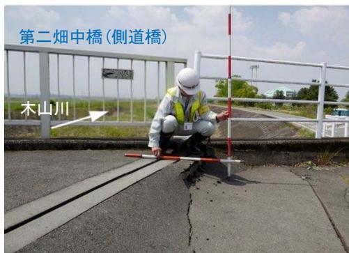
写真 2-2-3 橋台背面の沈下
