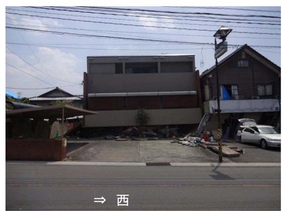
写真 5-1-4 県道沿いの3階建コンクリート店舗の倒壊
