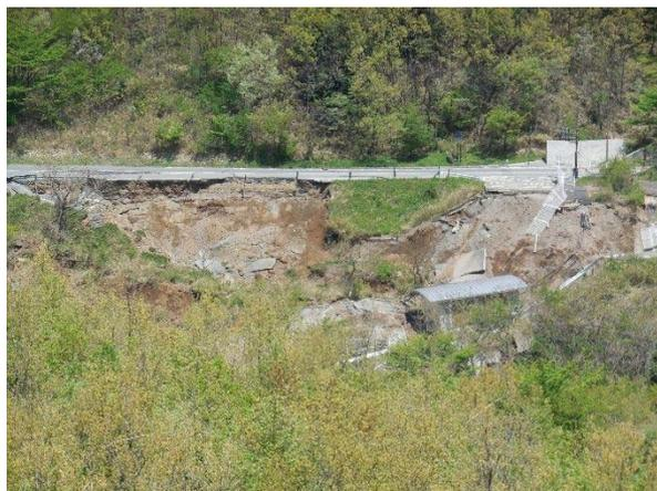
図 4-2-11 断層延長上の俵山バypass盛土の崩壊
