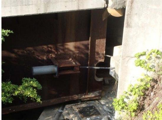
写真 5-2-14 終点側落橋防止装置 橋桁のズレを認め
