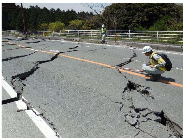
図 4-2-12 俵山バypassと旧道分岐点の「地割れ」
