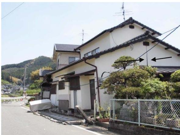
写真 5-1-10 地震断層の変位により、矢印先で壁が割れ、右横ずれの屈曲変位を示す。
