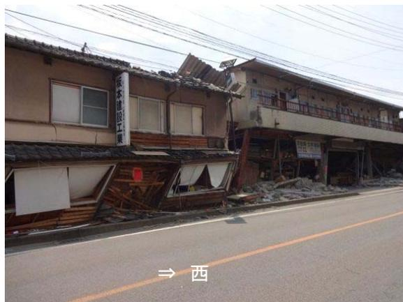
写真 5-1-3 県道沿いの簡易モルタル家屋の倒壊
