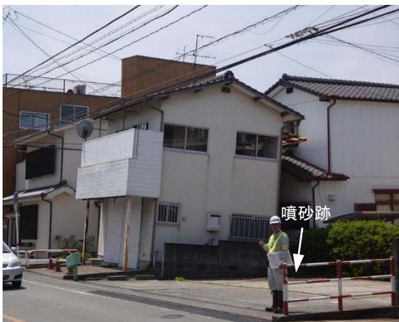
写真 2-3-2 液状化により傾いた家屋
