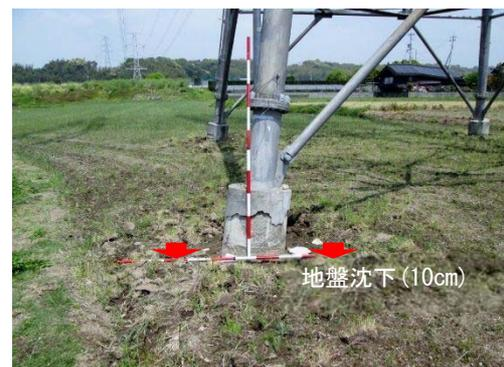
写真 2-2-2 鉄塔周辺の地盤沈下
