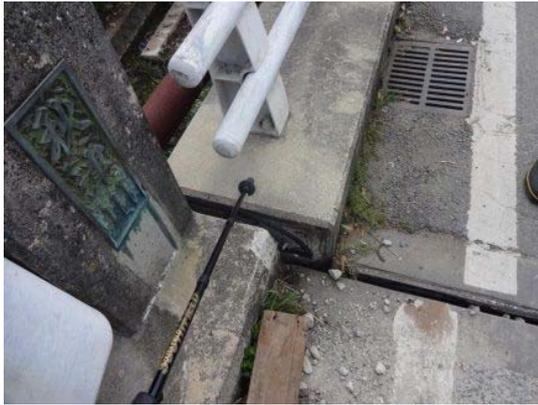
写真 5-2-7 橋桁とパラペット(橋壁)の間に水平変位が発生している。
