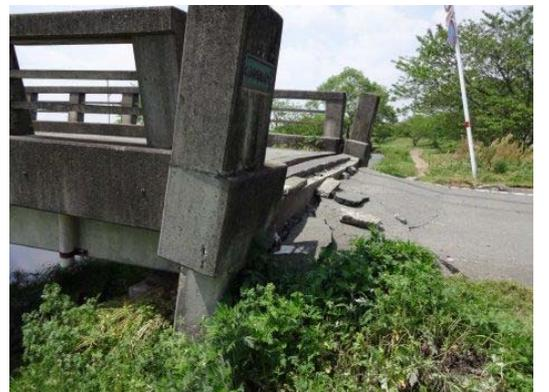
写真 5-2-4 盛土の沈下やパラペット(橋壁)の傾動が認められる。
