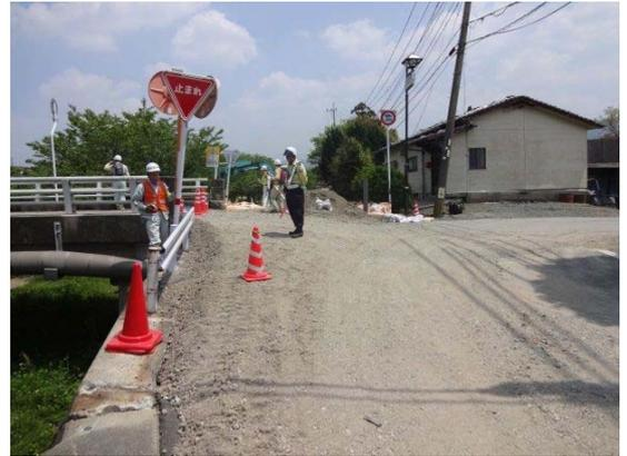
写真 5-2-8 段差部分に盛土を追加して、応急的に通行可能状態にしている。
