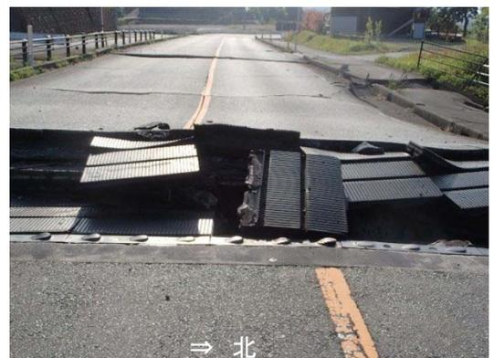
写真 5-2-13 大切畑橋終点側接続部 橋桁は 60cm の鉛直変位と 1m の南向き水平変位
