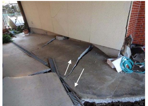
写真 5-1-11 白壁家屋の駐車場を横切り、家屋直下に伸びる地震断層。コンクリート板及び排水溝に右横ずれ変位が確認される里道に現れた地震断層は右の家屋をわずかにかわしている。電線が垂れているのは横ずれにより電柱の距離が短くなったためである。
