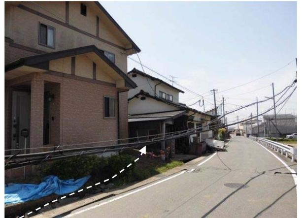
写真 5-1-9 地震断層は左の家屋をわずかにかわして、白壁の家屋の直下に伸びる。
