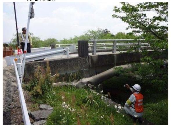
写真 5-2-6 盛土の沈下やパラペット(橋壁)の傾動が認められる。橋梁にガス管を取り付けてあり、盛土の沈下でガス管が屈曲している。
