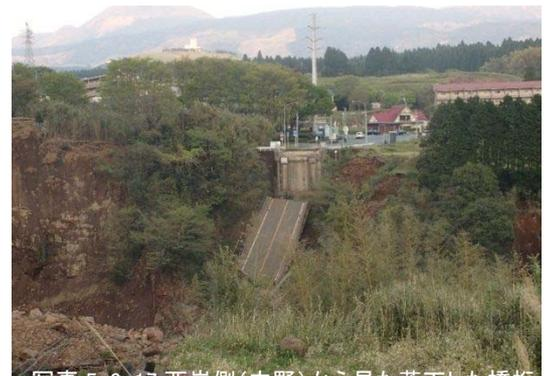
写真 5-2-17 西岸側(立野)から見た落下した橋桁
