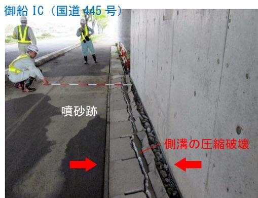
写真 2-2-5 御船 IC 付近の噴砂跡
