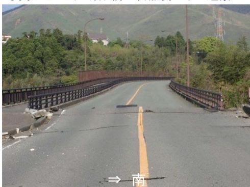
写真 5-2-12 大切畑橋基点側の接続部 橋桁は北へ 1m 変位
