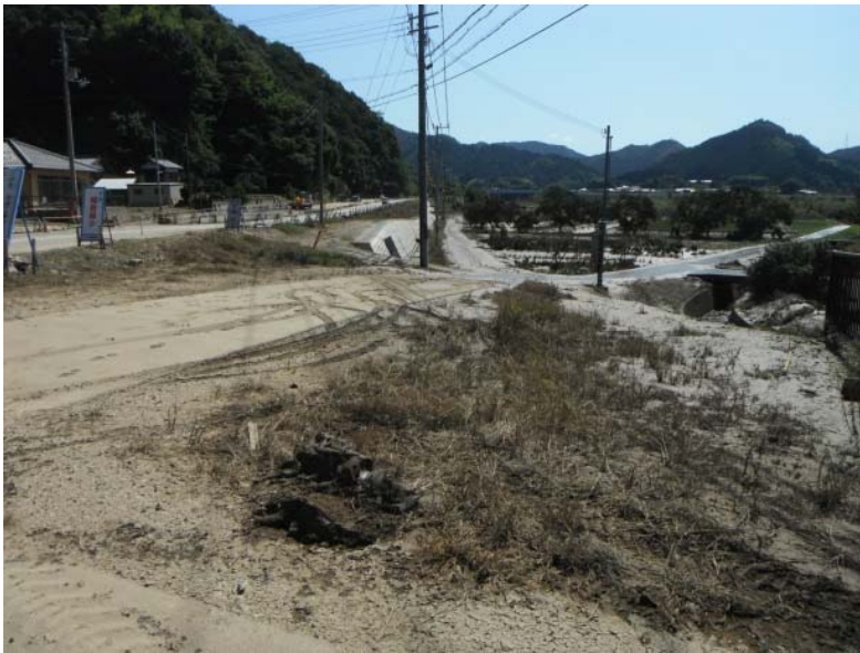
写真—1 下流側国道付近
