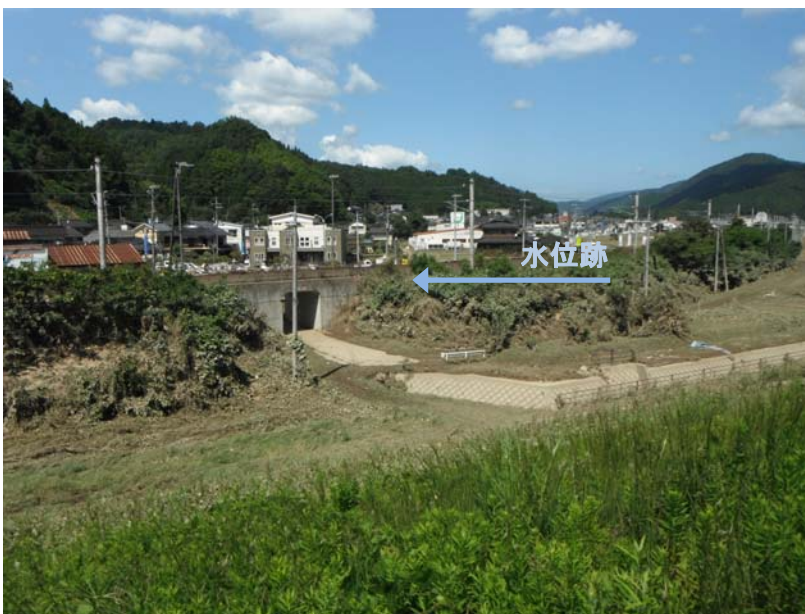
写真－7 新堤から堤内側 (KTR)
