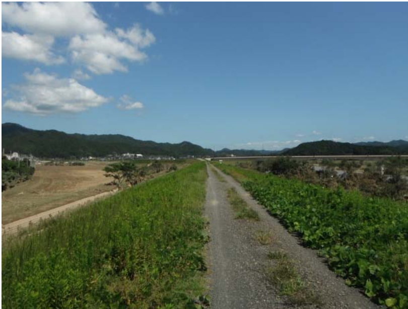
写真－ 8 新堤は越水の形跡なし
