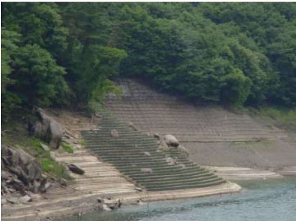
写真 7 マサ土の湖岸法面に施工された緑化工法
