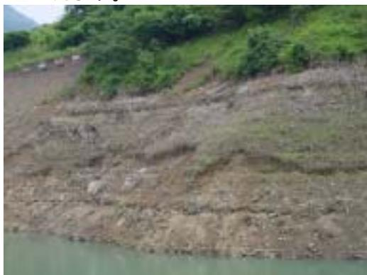
写真 3 波浪等により侵食が進む湖岸法面
