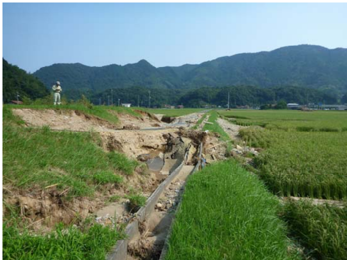
越水とパイピングによる堤防被害（川裏） 右：流されたアスファルト
