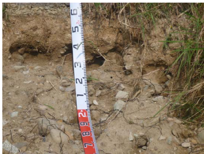
越水とパイピングによる堤防被害（川裏） 右：流されたアスファルト
