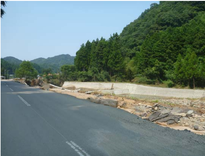
護岸の崩壊，浸食 右：河川合流部の護岸崩壊
