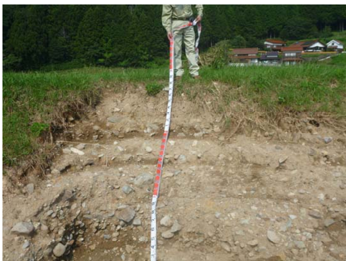
川裏側堤防被害 パイピング孔跡
