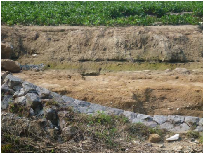
左：侵食された堤防断面 右：パイピング孔跡
