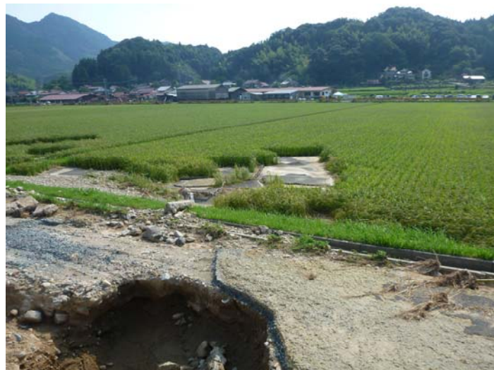
越水とパイピングによる堤防被害（川裏） 右：流されたアスファルト
