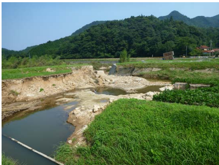
左：河川合流部の堤防崩壊 右：水路に土砂が詰まる
