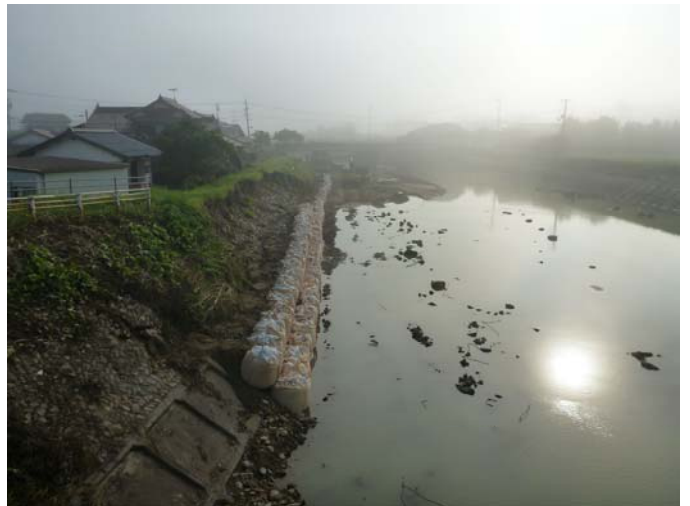
河川増水，越水による 左：橋台取り付け部の道路陥没（河川による侵食） 右：堤防の侵食
