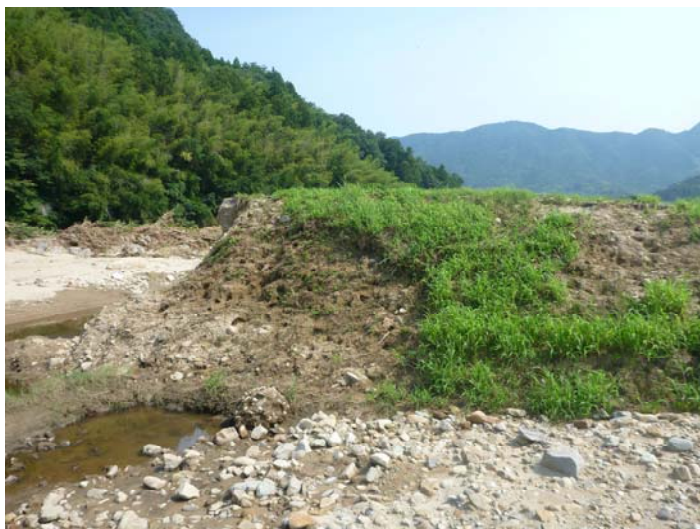
堤防及び取り付け道路の崩壊 右：パイピング跡
