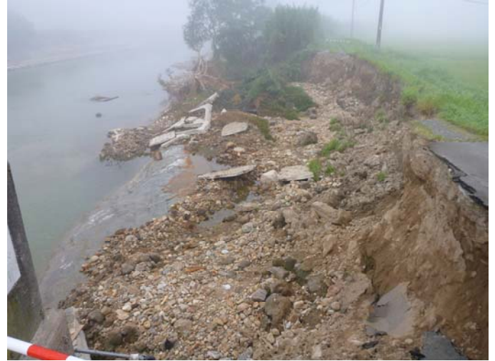
左：河川増水，越水による橋梁下流側堤防侵食と右：橋梁上流側護岸破壊
