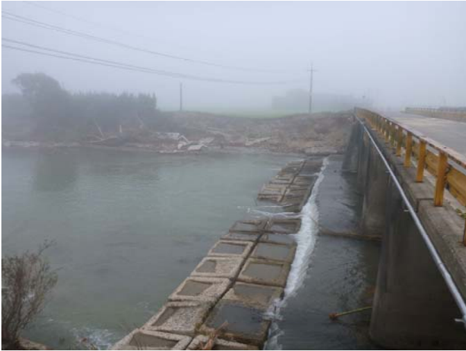
左：河川増水，越水による橋梁下流側堤防侵食と右：橋梁上流側護岸破壊
