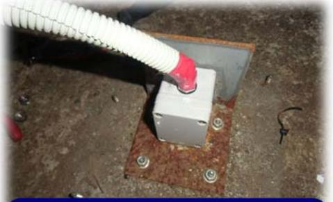
橋脚天端の感太郎 (センサー) モジュール
